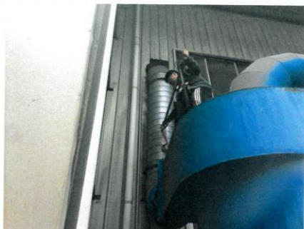
G1 浇注废气处理设施进口
