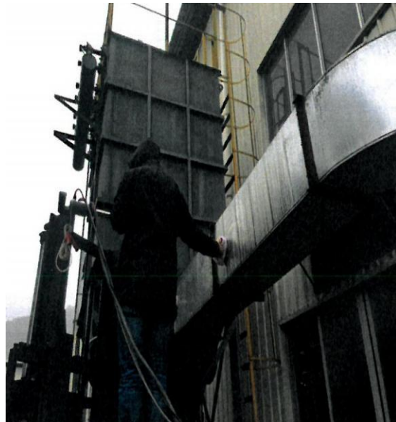
中频感应炉烟气处理设施
