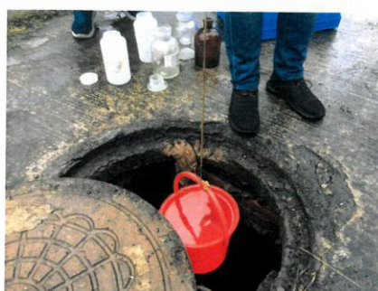
W1 污水总排放口
