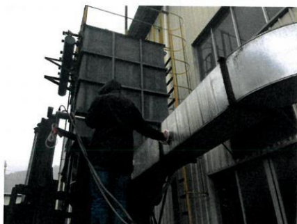
G2 粉尘废气处理设施进口
