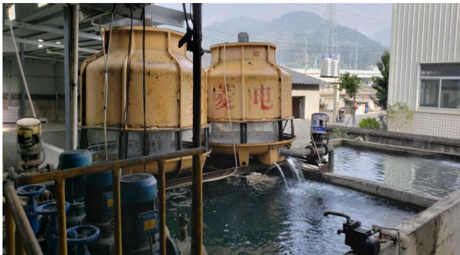
循环冷却水系统
