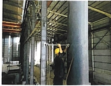
G5 浇注废气出口
