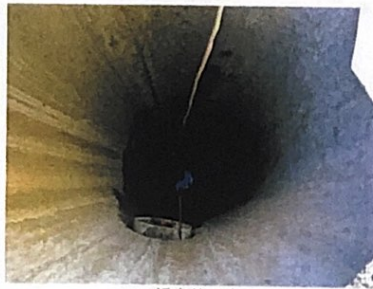
W2 污水处理出口
