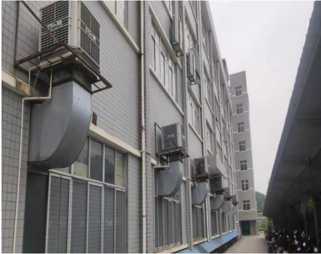
车间排气装置
