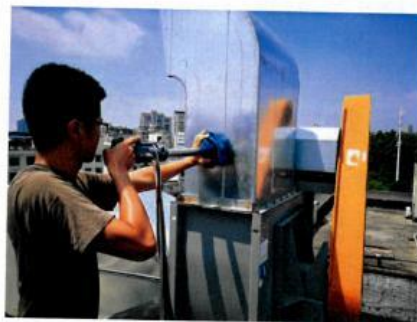
G8 油烟净化装置排气筒出口
