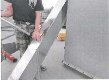
G1 废气处理设施出口 (石灰)
