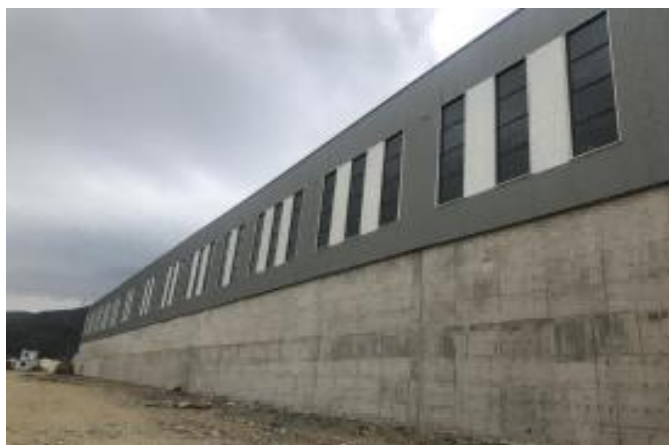
原料堆场及拌和站主楼全封闭建设
