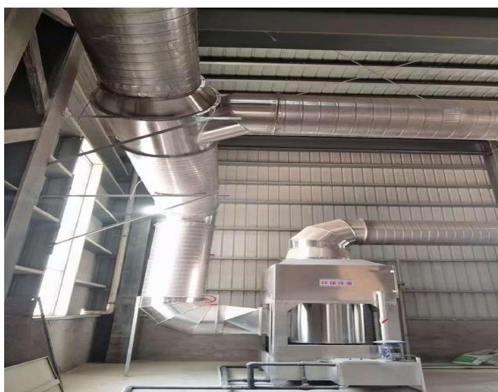
废气处理设施
